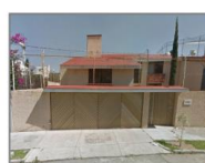
Foto de fachada
